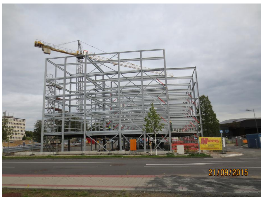
Baufortschritt im September 2015
